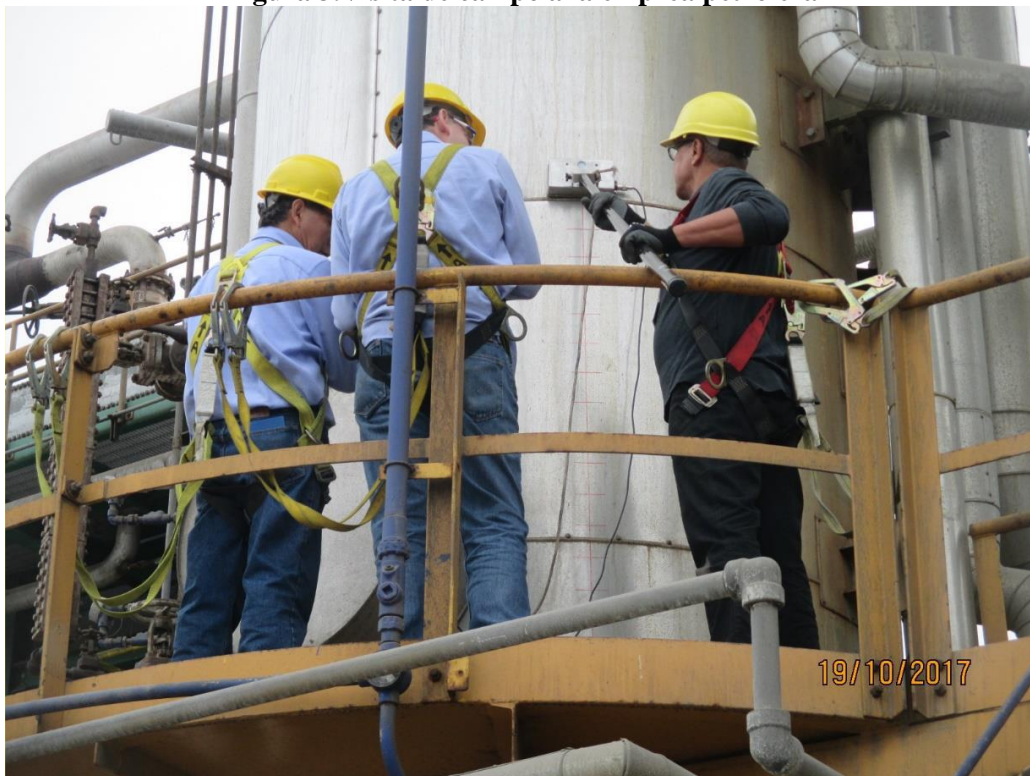
Figura 4. Aplicación en la columna de refinación del petróleo.
